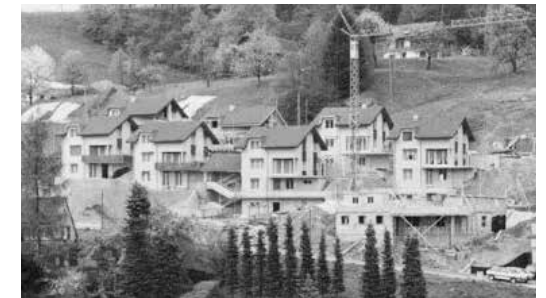
Die EFH-Siedlung im Bau
