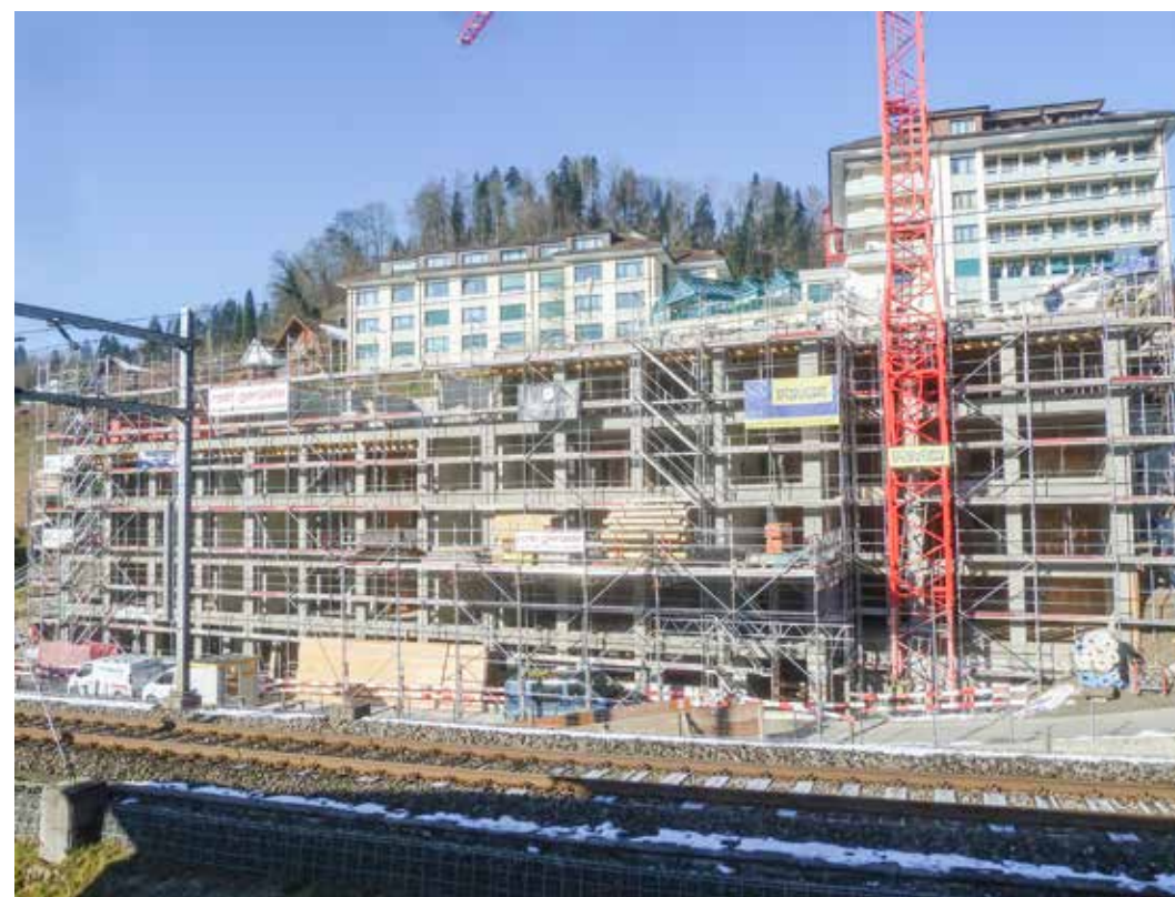
Baufortschritt am 13. Februar 2019
