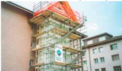
Zihlenfeld 11 | Einbau Lift 2002/2003
